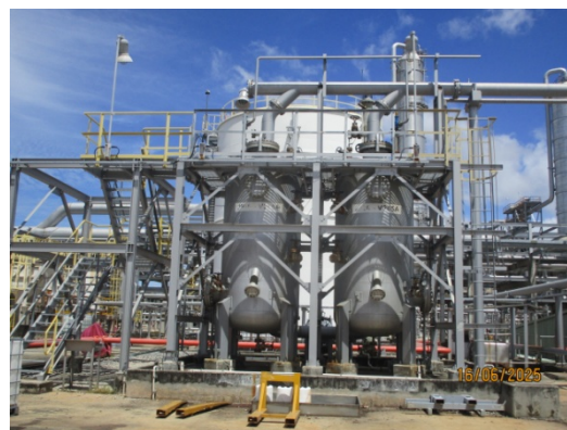
รูปที่ 32 ระบบบำบัดไอไฮโดรคาร์บอนจาก Holding Basin (Vapor Adsorber (2930-V205A/B))
