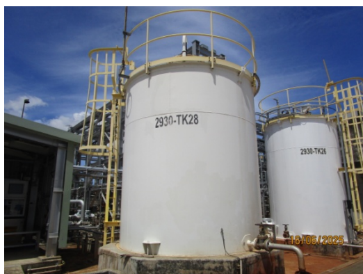
รูปที่ 34 หน่วยบำบัดปรอทในน้ำเสียจากกระบวนการผลิต (น้ำจาก Desalter) (NEW ETP)
