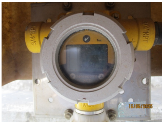
รูปที่ 65 ระบบตรวจจับก๊าซที่มีความเป็นพิษ (Toxic Gas Detector)
