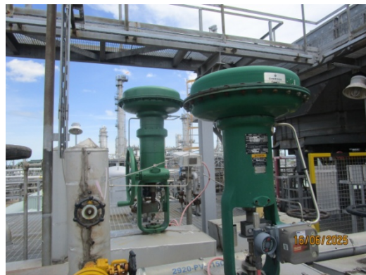
รูปที่ 48 Low Noise Valve
