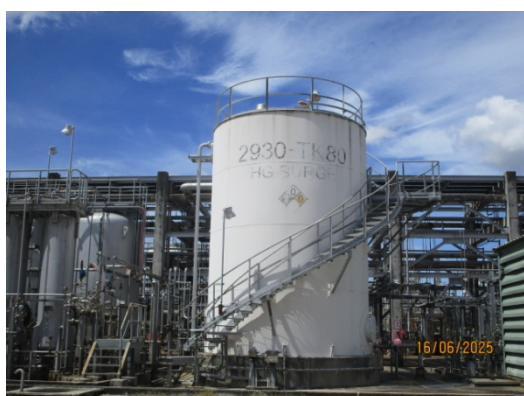
รูปที่ 15 ถังพักน้ำทิ้งปนเปื้อนปรอท (2930-TK80)
