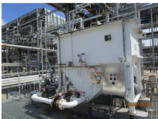
รูปที่ 21 หน่วยแยกน้ำมันออกจากน้ำ (CPI)
