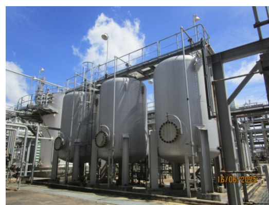
รูปที่ 28 Hg Adsorbent Filter สำหรับบำบัดน้ำเสีย ปนเปื้อนปรอทจากกระบวนการผลิต (น้ำจาก SWS)
