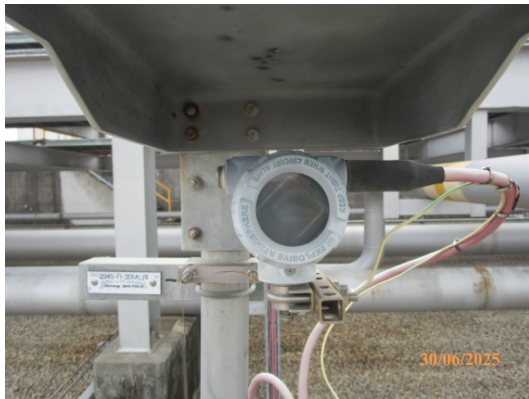
รูปที่ 85 Flow meter วัดอัตราการไหลของสารในท่อ
