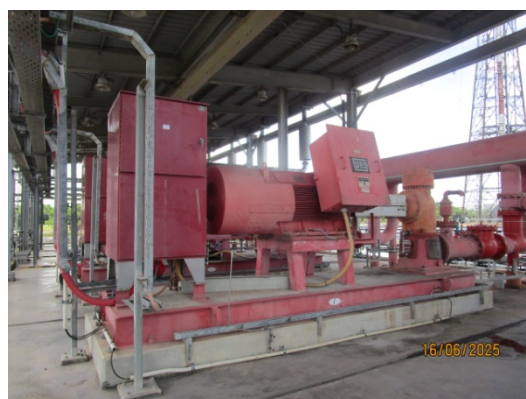
รูปที่ 58 ปั๊มสูบน้ำดับเพลิง
