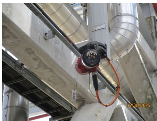
รูปที่ 52 Flame Detector
