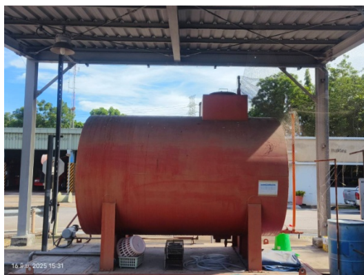
รูปที่ 55 ระบบโฟมดับเพลิง
