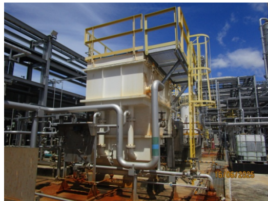
รูปที่ 24 หน่วยกำจัดสารแขวนลอย (DAF) (2930-TK23) ของ NEW ETP
