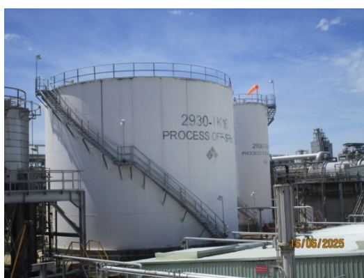
รูปที่ 27 ถังรวบรวมน้ำปนเปื้อนน้ำมันจาก กระบวนการผลิต (OWS) (2930-TK15, 2930-TK16)
