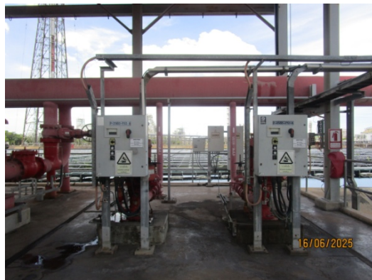
รูปที่ 60 เครื่องสูบน้ำรักษาแรงดัน
