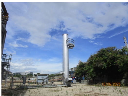
รูปที่ 33 หน่วยกำจัดไอไฮโดรคาร์บอนในระบบบำบัดน้ำเสีย (Vapor Disposal Unit)
