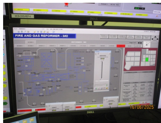
รูปที่ 94 หน้าจอ DCS แสดงการแจ้งเตือน ระบบตรวจจับก๊าซพิษที่ 5 ppm
