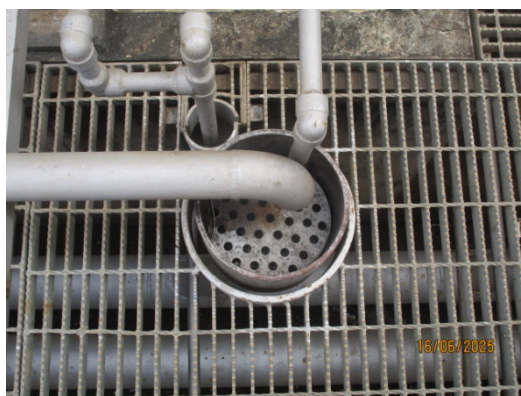
รูปที่ 14 ระบบระบายน้ำเสียจากกระบวนการผลิต ที่ปนเปื้อนน้ำมัน (Oil Water Sewer : OWS)
