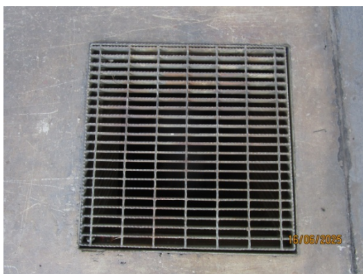
รูปที่ 13 ระบบระบายน้ำที่อาจปนเปื้อนน้ำมัน (Potential Oil Contaminated Water Sewer : POC)
