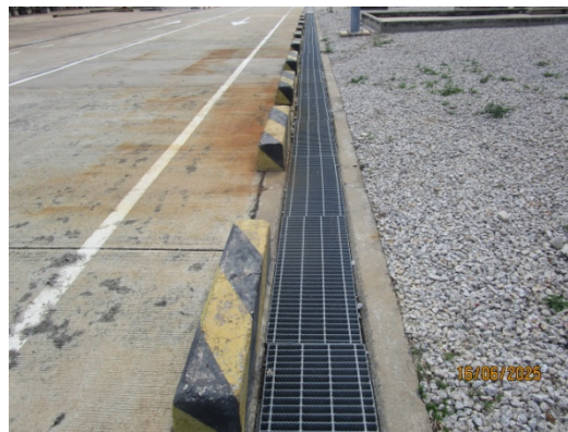
รูปที่ 12 ระบบรวบรวมน้ำไม่ปนเปื้อน (Clean Water Sewer : CWS)
