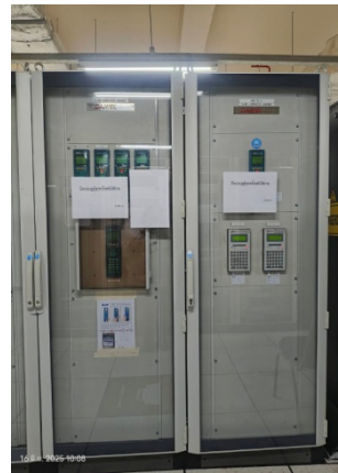
รูปที่ 86 Flow Comp ของ Tank Farm
