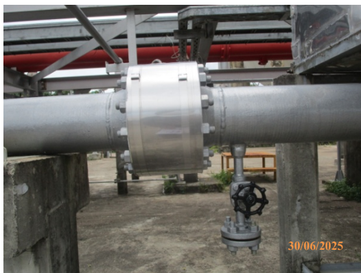
รูปที่ 87 Check Valve เพื่อป้องกันการไหลย้อนกลับ ออกจากถังรับที่ปลายทาง
