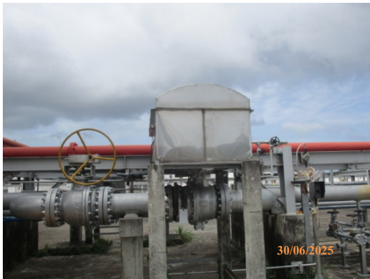
รูปที่ 91 Remote Shut-off-Value (ปลายทาง)
