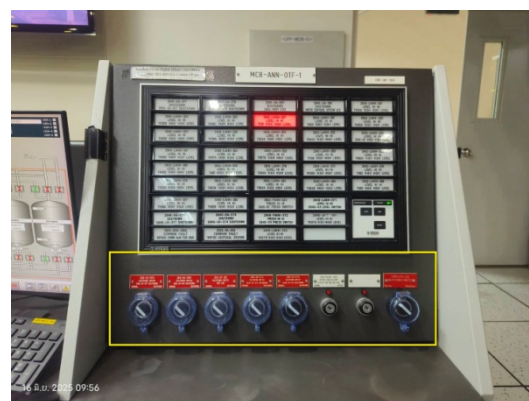
รูปที่ 90 Remote Shut-off-Valve (ต้นทาง)
