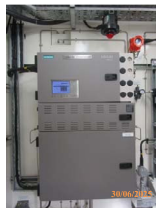
รูปที่ 10 เครื่องมือตรวจวัด THC Analyzer ที่ปล่อยระบายอากาศของ VRU
