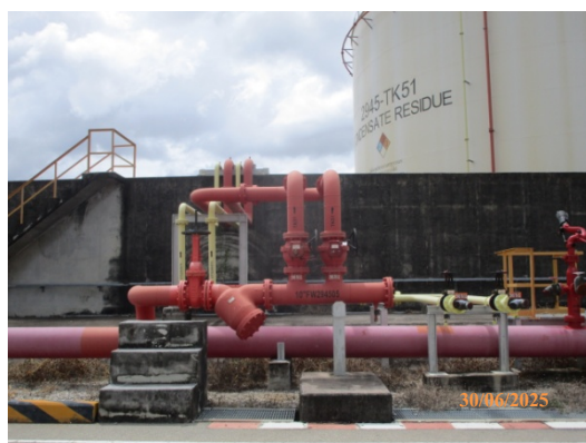
รูปที่ 61 ระบบฉีดพรมน้ำบริเวณด้านบนและรอบถังเก็บ
