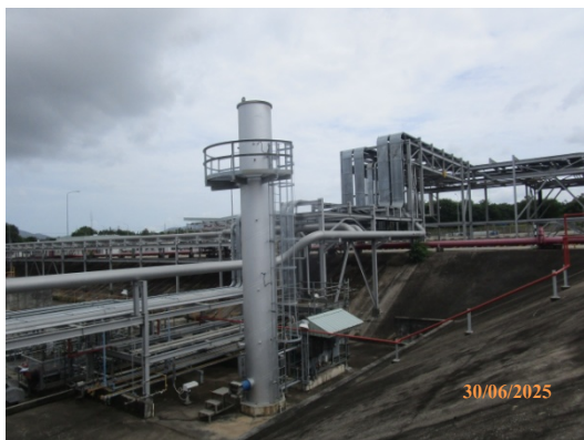
รูปที่ 11 ระบบกำจัดไอสารไฮโดรคาร์บอน จากการขนถ่ายสารไฮโดรคาร์บอนทางรถบรรทุก
