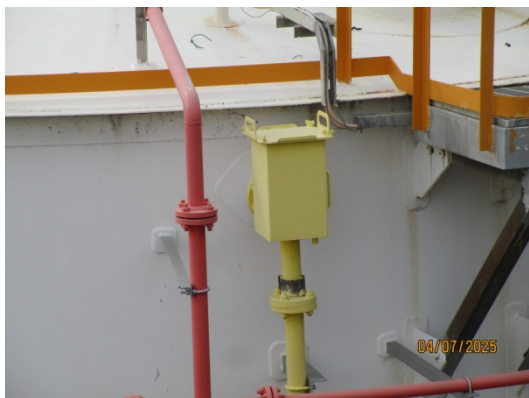
รูปที่ 81 Foam Chamber
