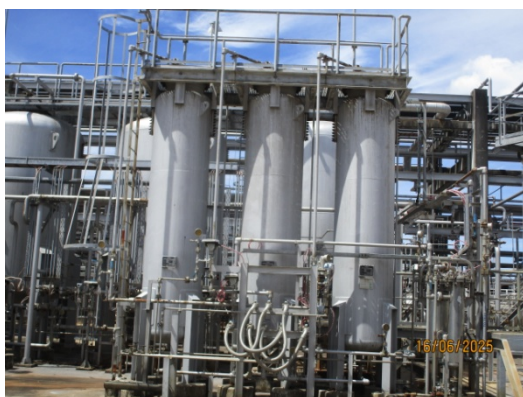
รูปที่ 19 Hg Treating Package สำหรับบำบัด น้ำปนเปื้อนปรอทจากถังเก็บฟลูออรีนคอนเดนเสท
