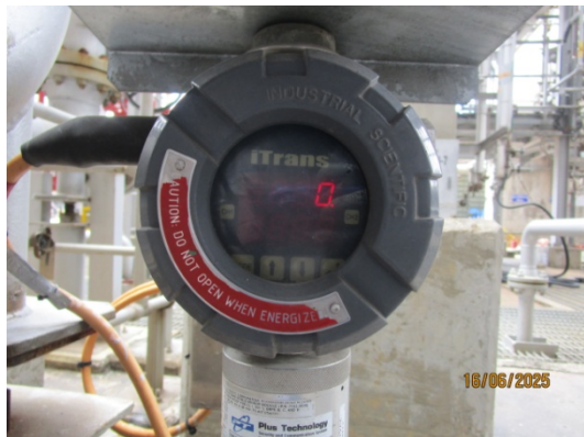
รูปที่ 53 Gas Detector
