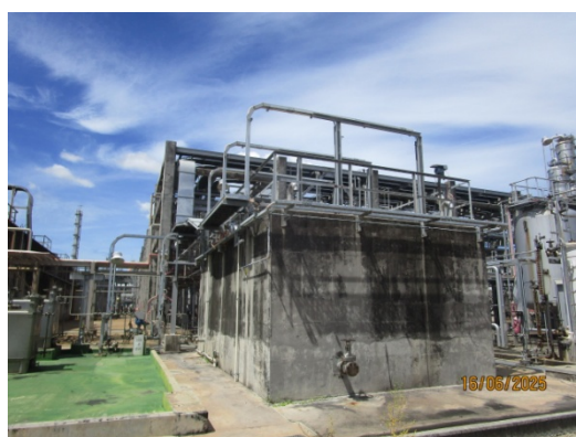
รูปที่ 16 หน่วยบำบัดน้ำเสียสำเร็จรูป (Sanitary Package) จากอาคารสำนักงาน (2930-ME 168)
