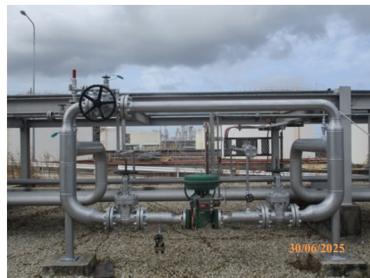
รูปที่ 88 วาล์วตัดแยกระบบ (Isolate Valve) ต้นทาง
